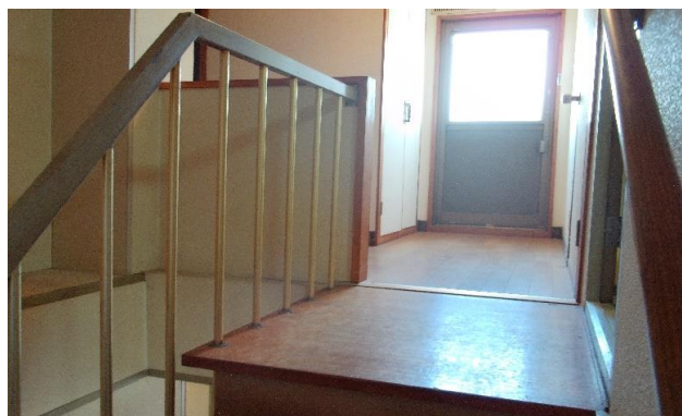
2F 廊下 ⑦
