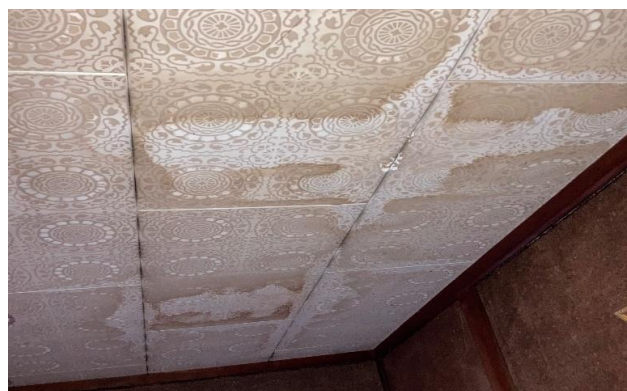
1F 和室 ④ 天井
